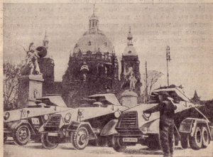
Рис. 380. Германские тяжелые 3-осные броневладельцы. Вариант с 20-мм автоматической пушкой и пулеметом.
