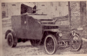
Рис. 216. Легкий броневый автомобиль Пежо с пулеметным вооружением. Машина представляет лишь исторический интерес и встречается только в польской армии.
