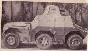
Рис. 11. Симметричное размещение осей на французском броневом автомобиле Берлие Т. V.-P. С.
