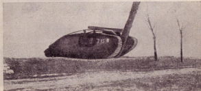
Рис. 166. Тяжелый танк марки IV с бревном для повышения проходимости, перевозимым на крыше.
