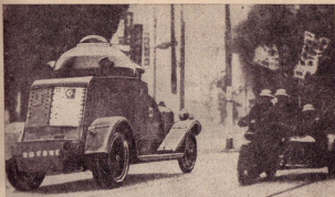
Рис. 82. Легкий броневомобиль Виккерс-Кросслей М. 25, вид сзади. Видно удлинение корпуса сзади для размещения водителя второго ряда (фото относится ко времени японских операций в Шанхае в 1931 г.).
